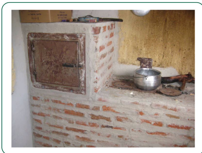
Fogão tipo FLQL de alvenaria, usando cimentotijolo, areia e chapas de metal - Projeto Terra Forte, Paraiíba. Fonte: AS-PTA (2014)
