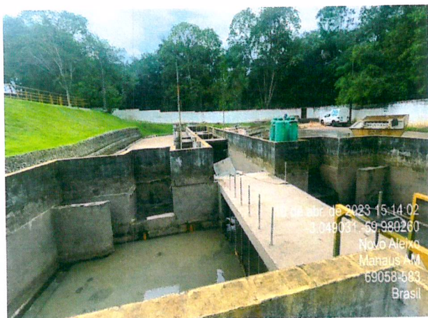
Fig. 14 e 15: Infraestrutura do sistema de tratamento de esgotos da ETE/Timbiras, tanques de recebimento de efluentes e tanques para tratamento aeróbico destes, atividade licenciada por este IPAAM.
