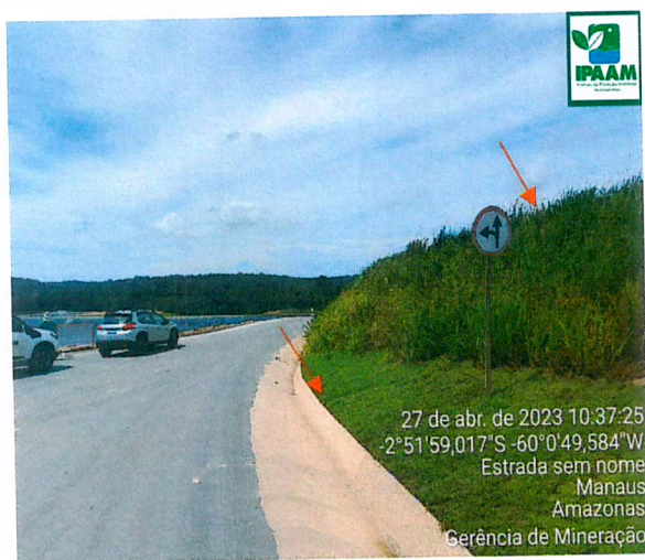
Fig. 02 e 03: Vias internas dotadas de dispositivos de coleta e transporte de águas pluviais que se encontram passando pelos últimos arranjos técnicos para se encontrarem aptas a receber o fluxo de veículos, necessários à operação do Aterro Sanitário da Empresa EcoManaus Ambiental.
