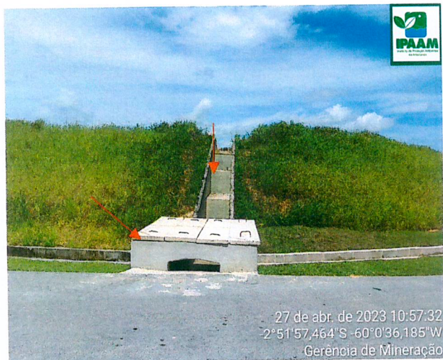
Fig. 04 e 05: A drenagem de águas pluviais está sendo concluída, principalmente a do entorno da célula, verificou-se que esta é robusta, pois foi levada em consideração os grandes declives. Os taludes de corte e aterro estão sendo contidos pelo plantio de gramíneas.
