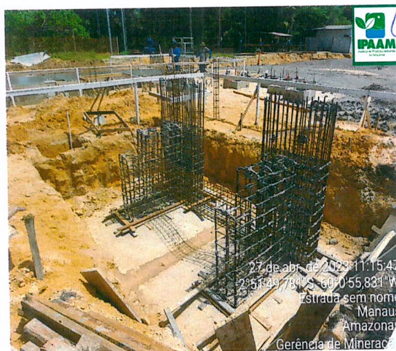
Fig. 10 e 11: Obras de implantação das balanças tipo rodoviárias, as quais farão o controle da volumetria de RSU recebido no Aterro Sanitário.
