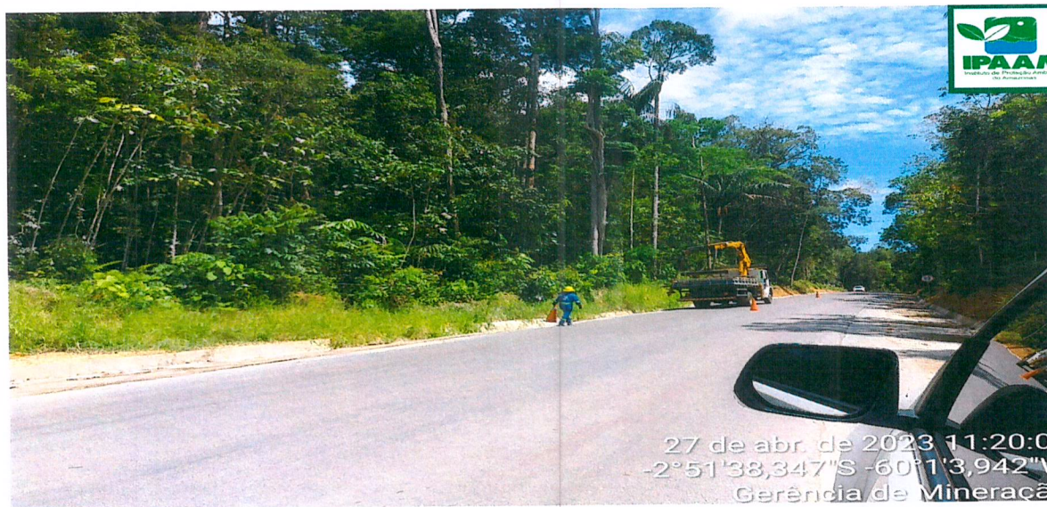
Fig. 19: Implantação de postes e posterior lançamento de Cabos para a eletrificação do empreendimento e iluminação do ramal do Itaúba.
