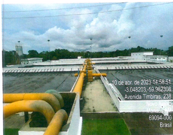
Fig. 14 e 15: Infraestrutura do sistema de tratamento de esgotos da ETE/Timbiras, tanques de recebimento de efluentes e tanques para tratamento aeróbico destes, atividade licenciada por este IPAAM.
