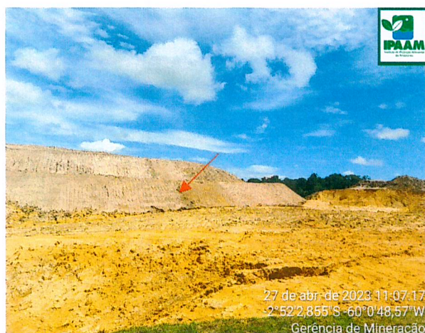
Fig. 12 e 13: Depósito de material de argiloso, onde se encontra armazenado aproximadamente 670 mil/m 3 de tal material, que será utilizado para cobertura do maciço de RSU. No detalhe, bacia de retenção de águas pluviais.
