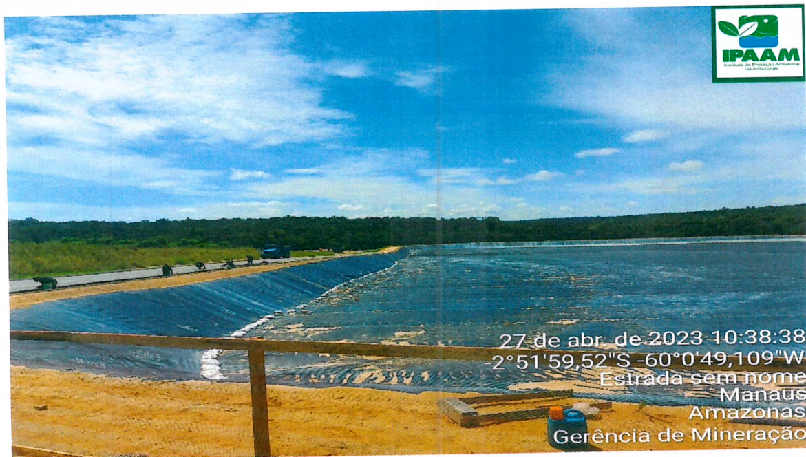
Fig. 01: Célula que compõem a primeira fase do projeto do Aterro Sanitário, infraestrutura, que se encontra pronta para receber drenagens de efluentes líquidos e gasosos, logo que resíduos sólidos sejam depositados no local.
