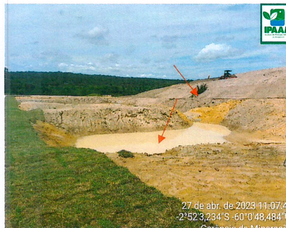
Fig. 12 e 13: Depósito de material de argiloso, onde se encontra armazenado aproximadamente 670 mil/m 3 de tal material, que será utilizado para cobertura do maciço de RSU. No detalhe, bacia de retenção de águas pluviais.
