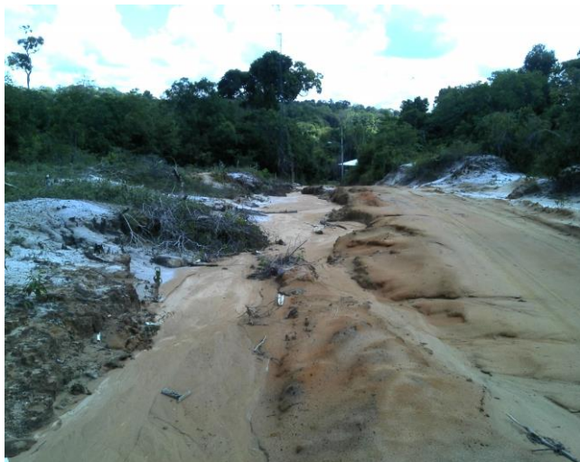
Fig. 09 e 10: Ramais sem infraestrutura operacional (drenagem superficial, pavimento e etc.), áreas de exploração mineral clandestinas (areia) e corpos d'água assoreados, compõem a situação a montante de degradação do igarapé do Leão.
