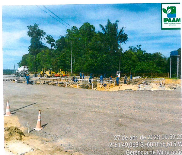
Fig. 10 e 11: Obras de implantação das balanças tipo rodoviárias, as quais farão o controle da volumetria de RSU recebido no Aterro Sanitário.
